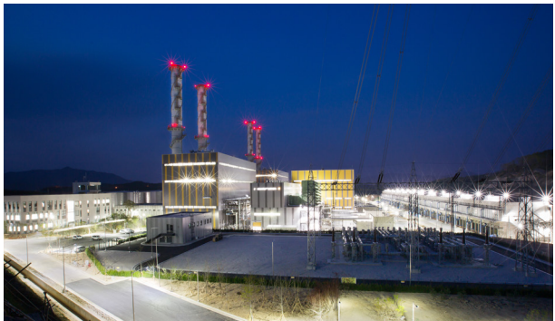
포천 CCPP 전경
